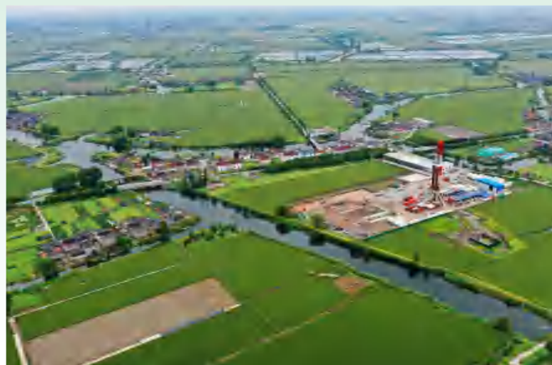
↑ 华东工程：全面普及一体化随钻治理技术，实现了工业污水“零排放”、废弃岩屑再利用。
