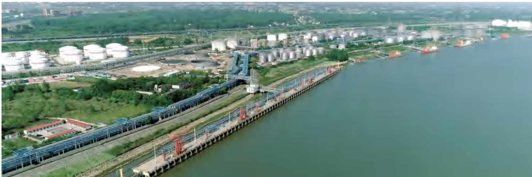
↑ 扬子石化：建设投运船舶洗舱站和绿色供汽中心，建成 4.7 公里长江沿线绿色风光带，“长江最美石化湾”成功入选集团公司“美丽石化 - 清洁美丽基层”，荣获“江苏省四星级绿色港口”称号。
