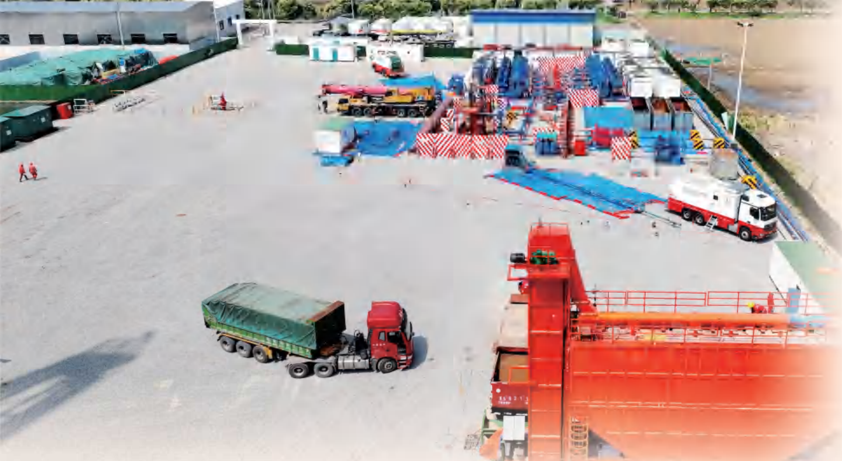
← 华东石油局：2023 年研发全自动加砂系统，顺利完成页岩油井的储层改造，该系统供砂能力达到每分钟 3 立方米，是传统吊装加砂的 4 倍，减少 4 名吊装作业人员，费用降低 80%；取消吊装登高作业，实现本质安全。
