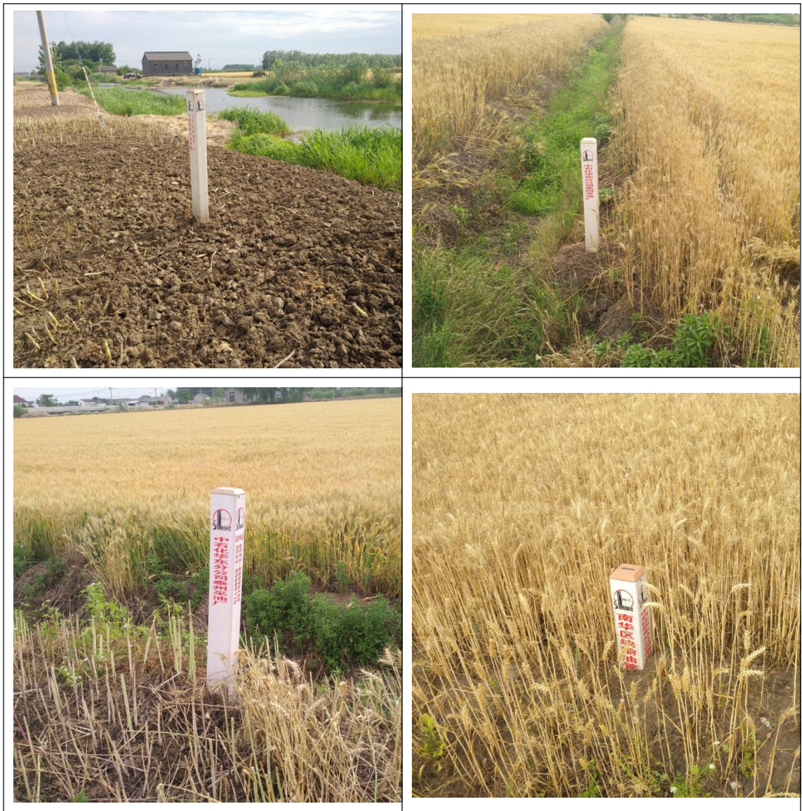
图 5.4-3 管线上土壤恢复照片
