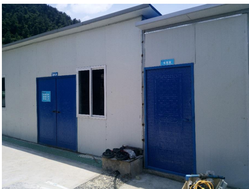
图 2.1-3 处理站内化验室
