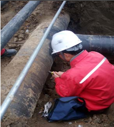
防腐层剥离检测
