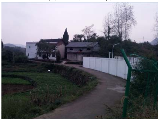
图 6-4 砖石结构围墙
