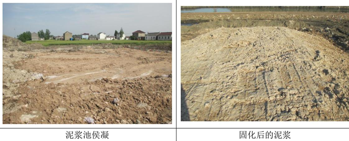
图 4-6 钻井泥浆和岩屑处置
