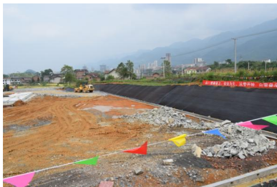
196 平台临时边坡密目网覆盖
