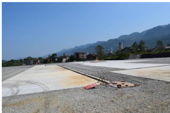
196 平台井场碎石铺垫及基础硬化
