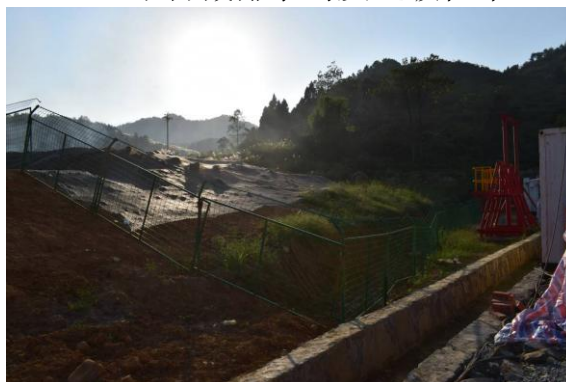
197 平台临时边坡密目网覆盖
