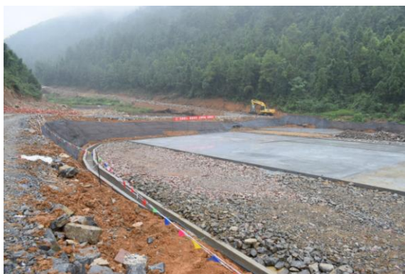
199 平台边坡密目网临时覆盖
