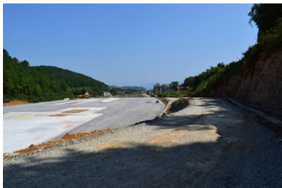
199 平台井场硬化及碎石铺垫
