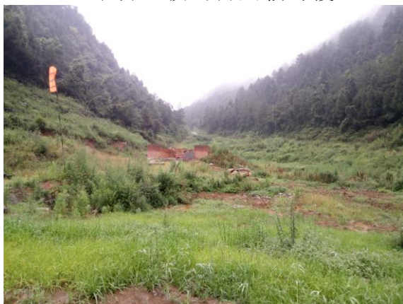
199 平台北侧正在拆除放喷池
