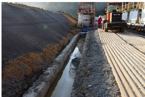
197 平台截排水沟及边坡密目网覆盖
