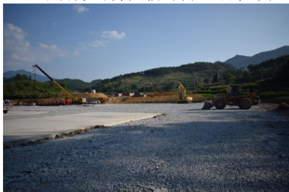
197 平台井场碎石铺垫及硬化
