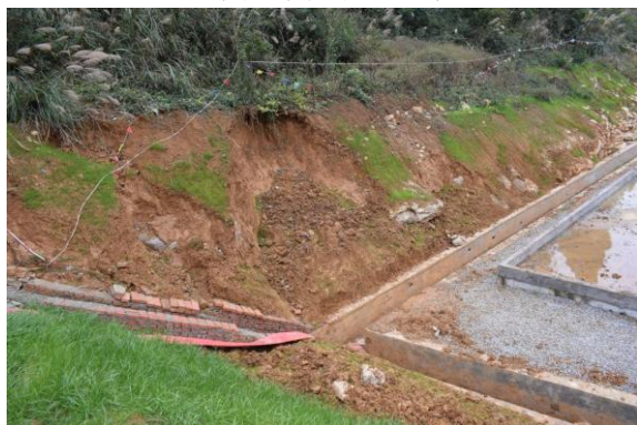
199 平台截排水沟及边坡植草
