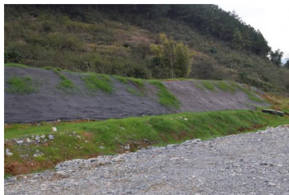
197 平台表土堆存密目网覆盖
