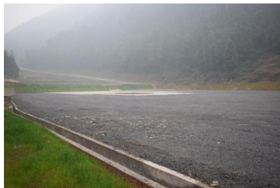
199 平台井场周边临时占地植草绿化
