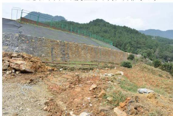
填方边坡底部挡墙及边坡密目网覆盖
