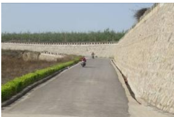
进场道路及护坡
