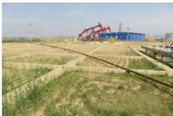
W12 平台临时占地恢复
