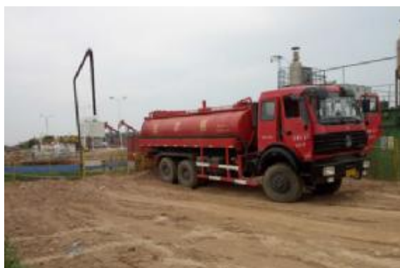
罐车拉水入调储池
