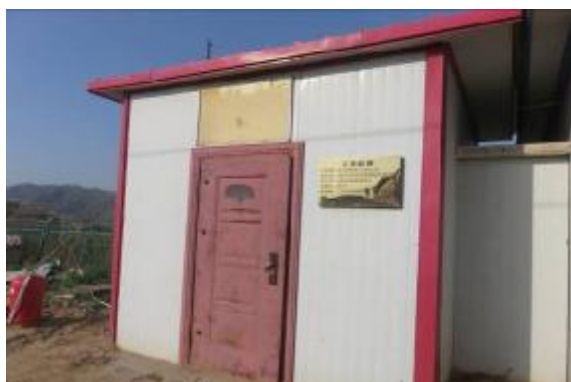
生活污水处理站操作间
