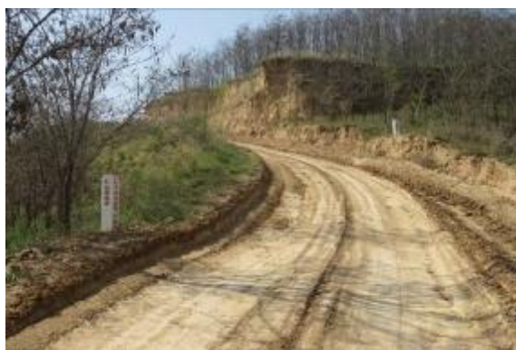
输水管线警示牌
