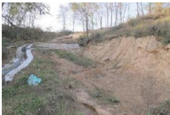
集气管线恢复截水沟挡水坝
