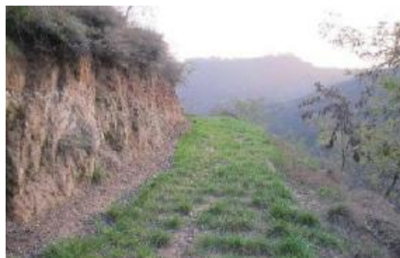
施工便道恢复
