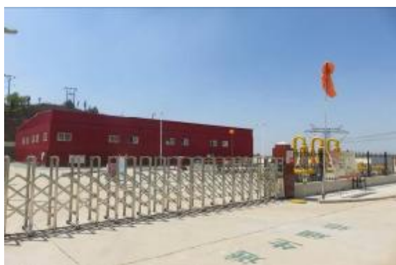
2#集气站压缩机区域（东、南围挡）
