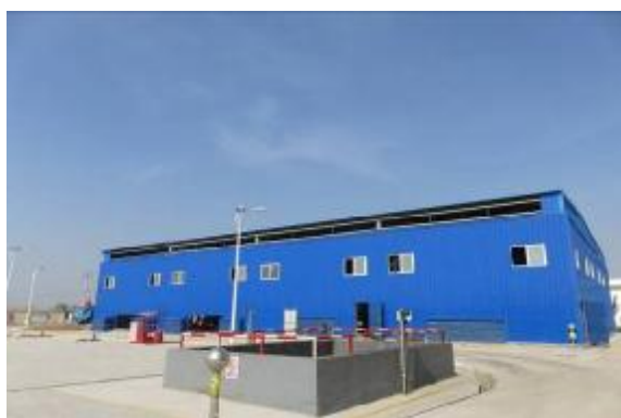
1#集气站压缩机区域（东、南、北围挡）
