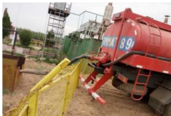
罐车拉水入调储池
