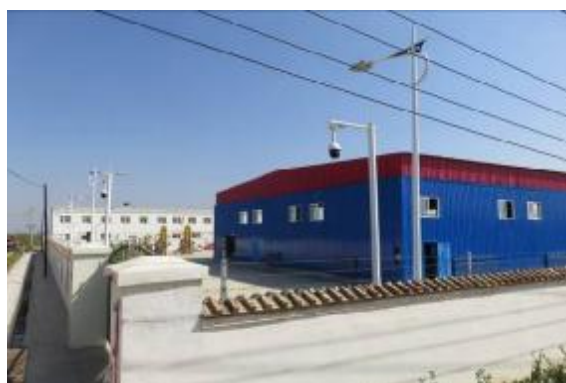
3#集气站压缩机区域（南、西围挡）
