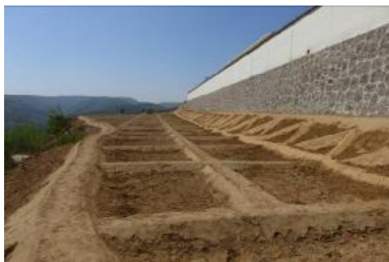
场外浆砌石护坡及场地平整
