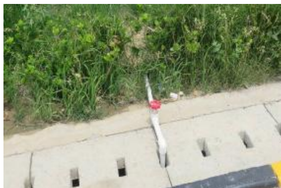
绿化洒水管线
