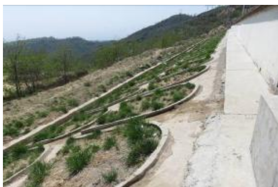
场外浆砌石护坡
