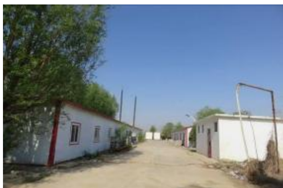
场地内废弃的建筑物
