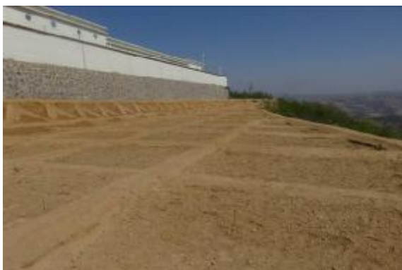
场外浆砌石护坡及场地平整
