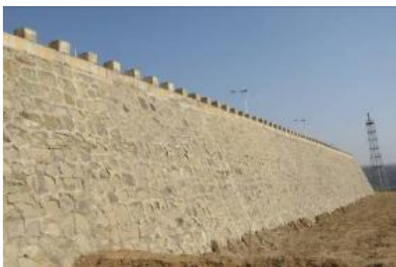
场地西侧护坡
