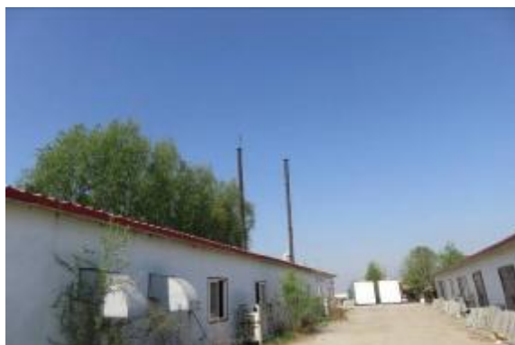
延 1 倒班点供热锅炉房（停用）
