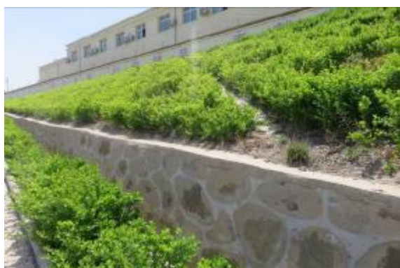
场外浆砌石护坡
