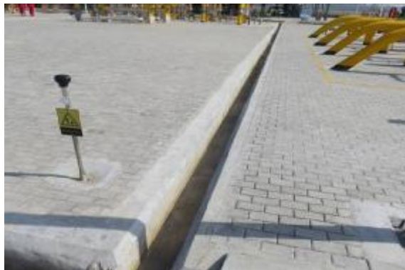
场地硬化及排水沟
