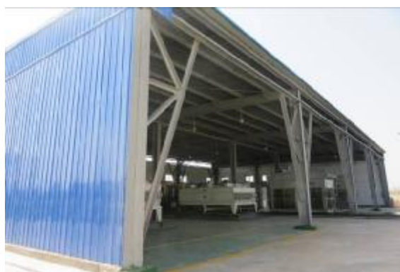
1#集气站压缩机区域（西未围挡）
