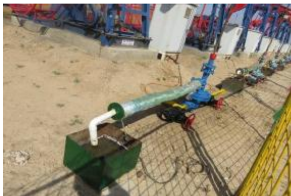
平台采出水收集（槽下地下管线入污水池）
