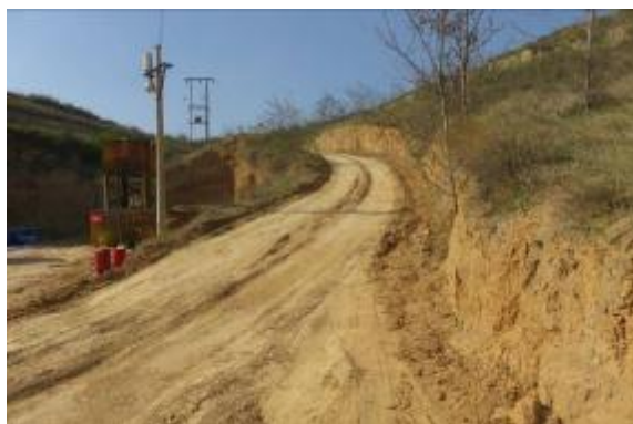
新建井场道路
