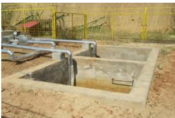
W13 平台污水池及提升管网（至输水管线）
