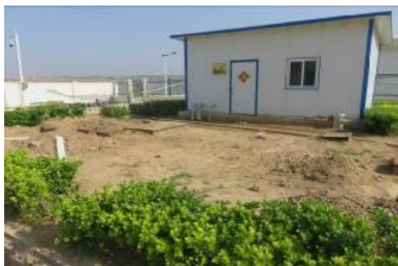
地埋式生活污水处理站
