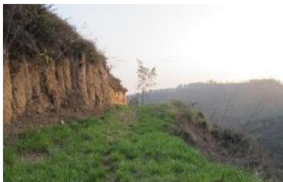
施工便道恢复
