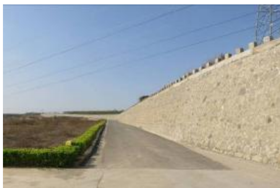
进场道路及护坡
